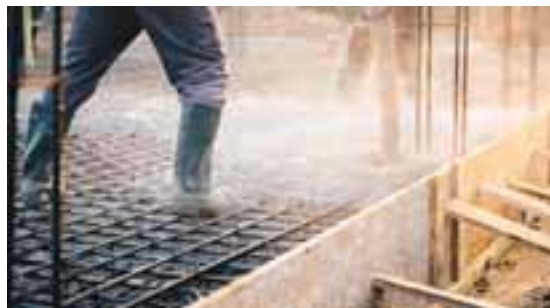
(b): Calcestruzzo gettato in opera per un ponte stradale
