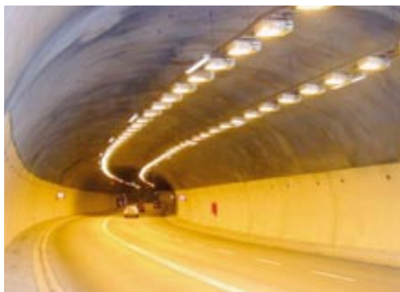
Fig. 6: L'applicazione di pannelli in cemento bianco riduce l'esigenza di illuminazione in gallerie sotterranee.
