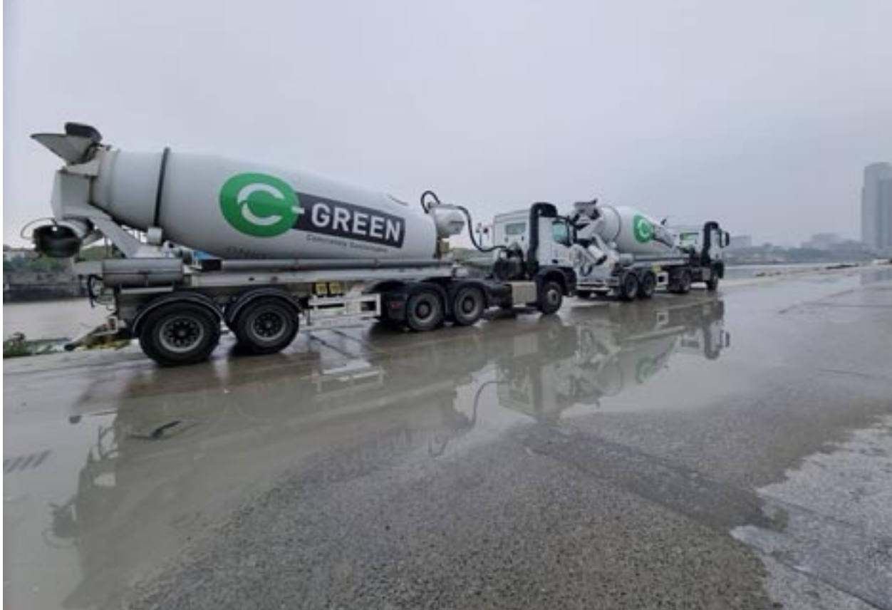
Autobetoniera che trasporta calcestruzzo a basse emissioni di CO 2 , C-Green, Bruxelles, Belgio
