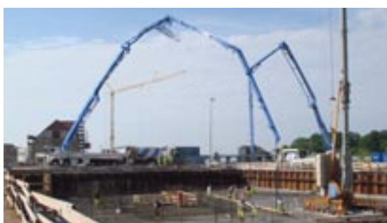
(b): Calcestruzzo posato in cantiere da Unicon, cemento grigio, Danimarca
