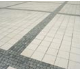
Pavimentazione in piastrelle, cemento bianco
