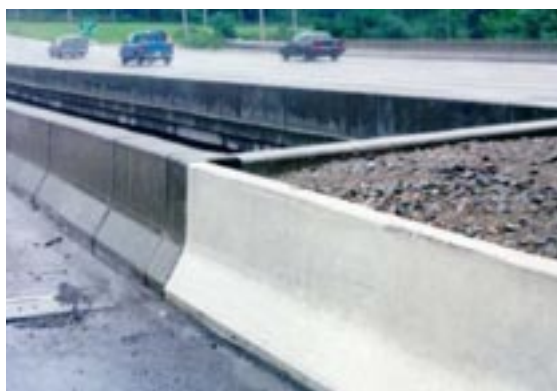
Fig. 8: Barriere stradali in calcestruzzo grigio verniciate di bianco. Illustrano il pericolo per la sicurezza e dei costi aggiuntivi per la verniciatura.
