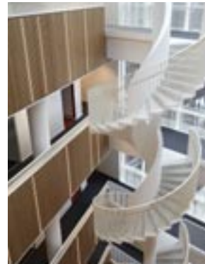
Scala negli uffici Aarsleff in ultra-high performance concrete, cemento bianco, Danimarca
