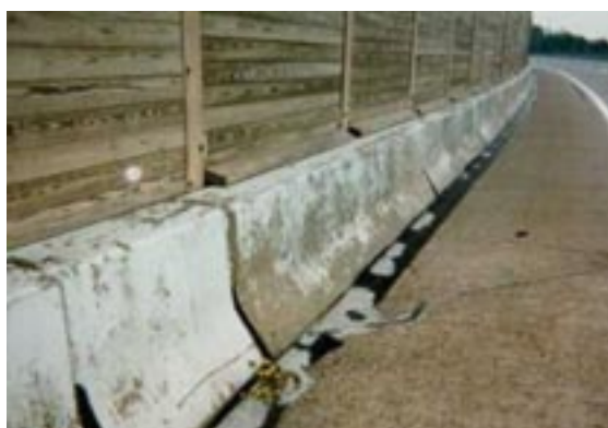
Fig. 8: Barriere stradali in calcestruzzo grigio verniciate di bianco. Illustrano il pericolo per la sicurezza e dei costi aggiuntivi per la verniciatura.
