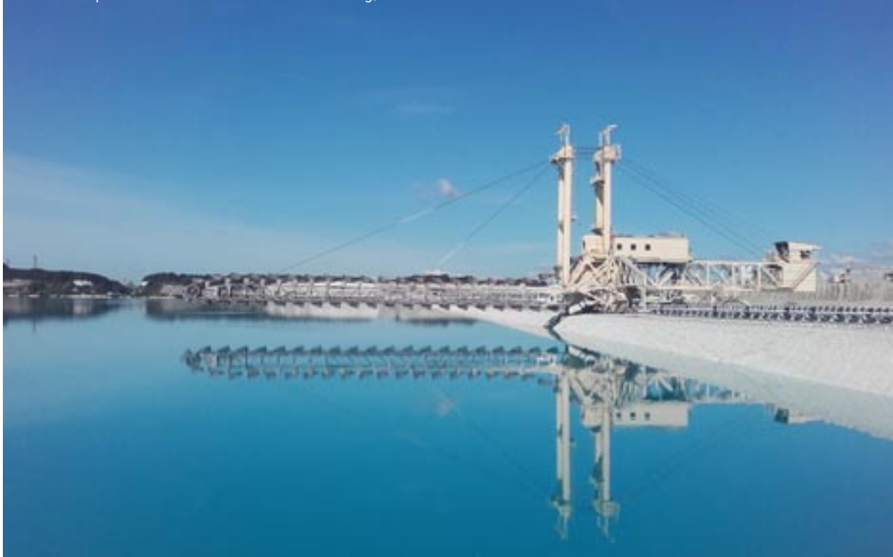
Macchina per l'escavazione nella cava di Aalborg, Danimarca
