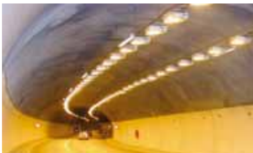
L'applicazione di pannelli in cemento bianco riduce l'esigenza di illuminazione in gallerie sotterranee.
