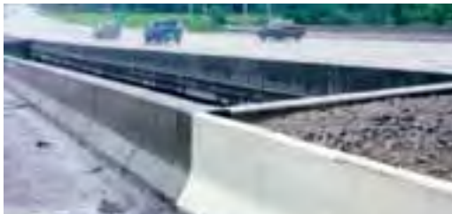
Barriere stradali in calcestruzzo a base rispettivamente di cemento grigio e bianco, che illustrano il vantaggio in termini di visibilità del calcestruzzo bianco in condizioni di bagnato.
