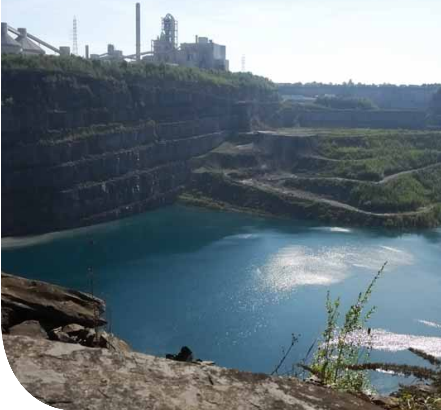
Impianto di cemento grigio, Gaurain, Belgio
