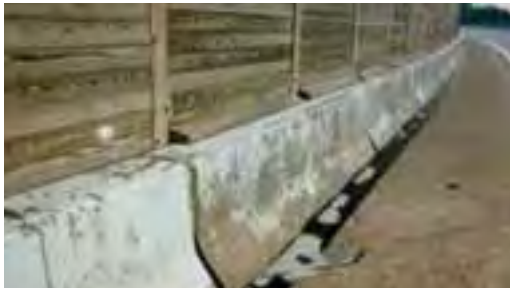
Barriere stradali in calcestruzzo grigio verniciate di bianco. A testimonianza del pericolo per la sicurezza e dei costi aggiuntivi per la verniciatura.
